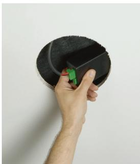
Das verlegte Lautsprecherkabel abisolieren und mitgelieferten Phoenix-Stecker anschrauben.
