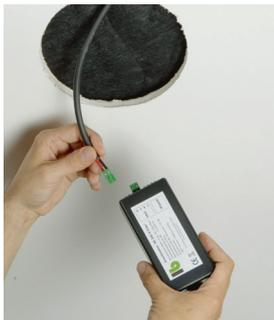
Bei zu kleiner Öffnung besteht die Gefahr, dass die Decke beschädigt wird und Haltefedern brechen (gehärteter Edelstahl). Bei zu großer Öffnung ist der nötige Halt des Lautsprecher nicht gewährleistet.
